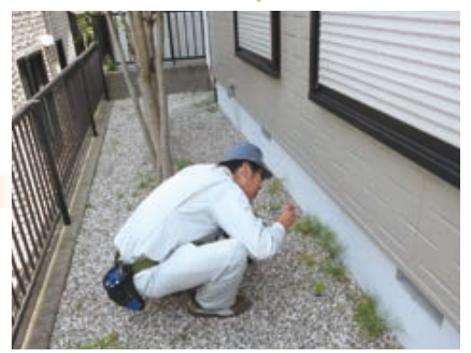
② 基礎のチェック。0.5mm以上のクラックや深さ20mm以上の欠損などを目視、計測する
