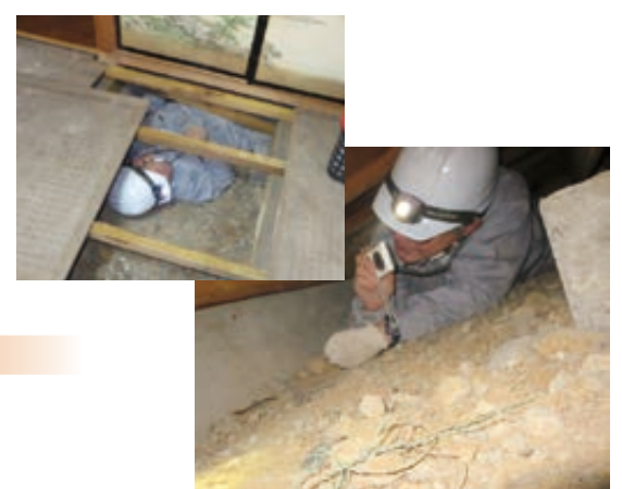
④ 床下点検口から床下に潜り、劣化状態やシロアリの害を検査する
