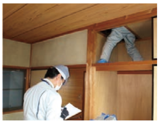
⑤ 小屋裏点検口から天井に上り、雨漏りや劣化状況などを点検する
