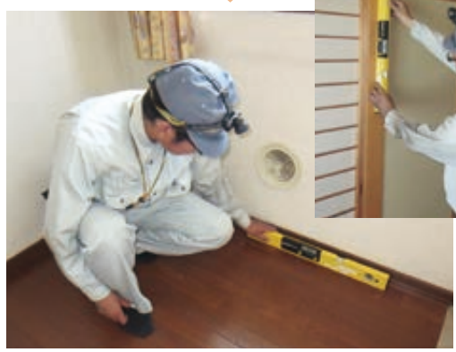
⑥ 床や柱、内壁の傾斜が6/1000以下であることを計測する
