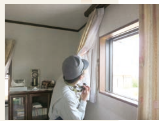
⑦ 窓枠を点検し、雨漏りの有無を確認する
